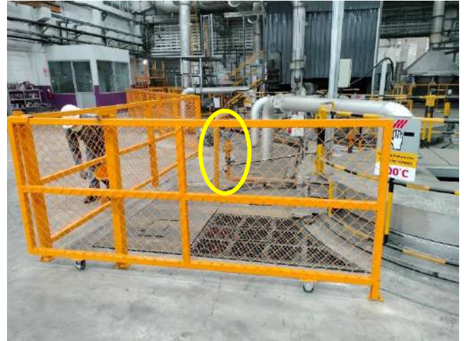
รูปที่ 8 จุดติดตั้งวาล์วจะอยู่ด้านบนกระทะทุกจุด
